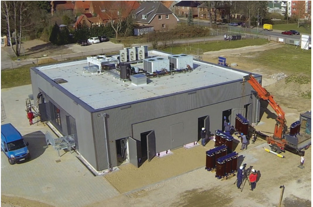
■ Abb. 13.17 Batteriekraftwerk der WEMAG/Younicos AG auf Basis von Lithium-Ionen-Akkus in Schwerin, Mecklenburg-Vorpommern. Aufnahme beim Einbau der Transformatoren (Quelle: Younicos AG)
