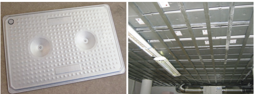
■ Abb. 13.43 PCM-Speicherelement ( links ), das an der Decke eines Besprechungsraums installiert wurde ( rechts ) (Quelle: [94])
