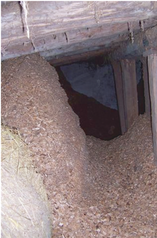
■ Abb. 8.67 Biomasselagerung am Beispiel von Hackschnitzel in einer offenen Scheune
