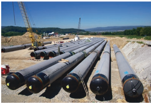
■ Abb. 8.47 Bau des Erdgas-Röhrenspeichers bei Urdorf, Schweiz (Quelle unbekannt)
