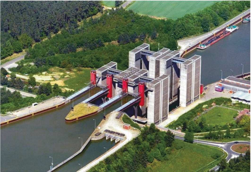
■ Abb. 9.42 Schiffshebwerk Lüneburg mit der größten potenziellen Einzelspeicherkapazität bei einer Fallhöhe von 38 Metern [93]
