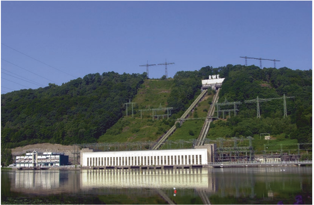
▣ Abb. 13.8 Koeppenwerk Herdecke, Pumpspeicherwerk der RWE AG mit 153 MW im Amprionnetz (Quelle: RWE Power AG)
