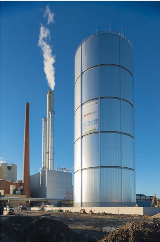
■ Abb. 14.4 Wärmespeicher des Heizkraftwerks Sandreuth in Nürnberg zur Flexibilisierung der KWK inklusive Power-to-Heat mit einer Höhe von 70 m (Quelle: N-Ergie Kraftwerke GmbH)
