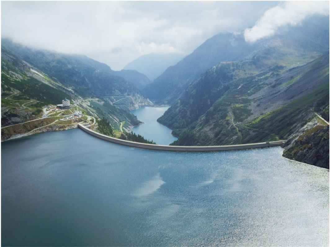
■ Abb. 13.14 Pumpspeicher Malta Oberstufe in Österreich, der mit 26 Tagen Ausspeicherdauer den Charakter eines Langzeitspeichers hat (Quelle: Verbund AG)
