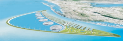
■ Abb. 9.33 Offshore-Ringwallspeicher-Hybridkraftwerk mit Windkraftanlagen und solarthermischen Kraftwerken sowie Nutzung der gewonnenen Landfläche für Wohnungen [41]
