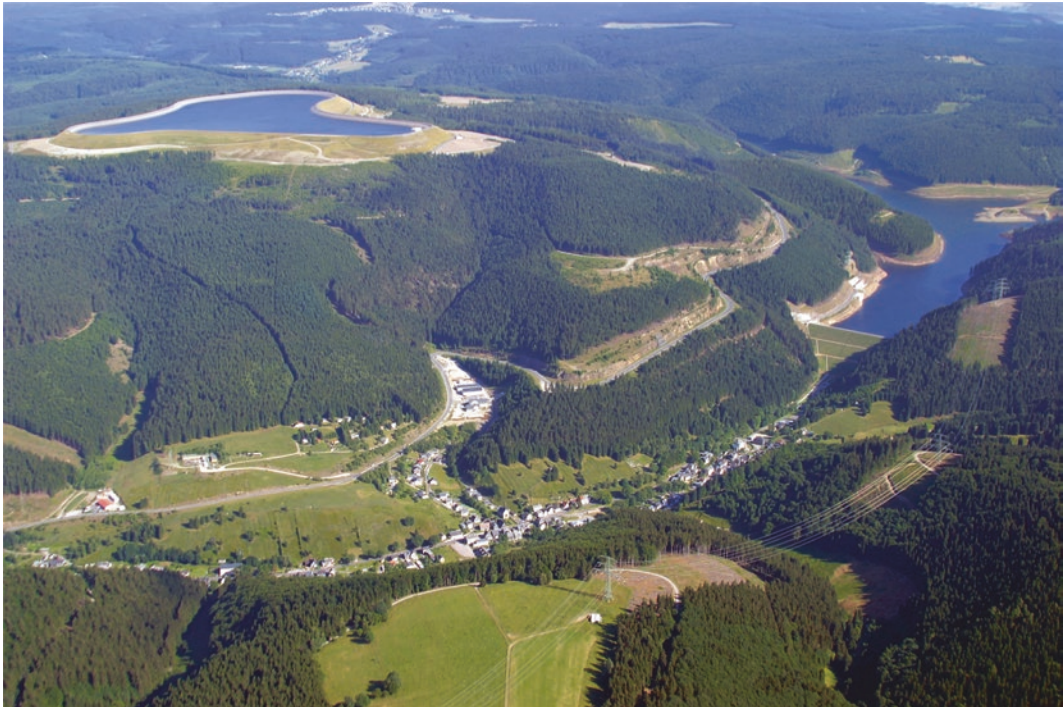
■ Abb. 13.7 Oberbecken des Pumpspeichers Goldisthal mit einem Speichervolumen von ca. 12 Mio. m 3 Wasser (Quelle: Vattenfall Europe AG)
