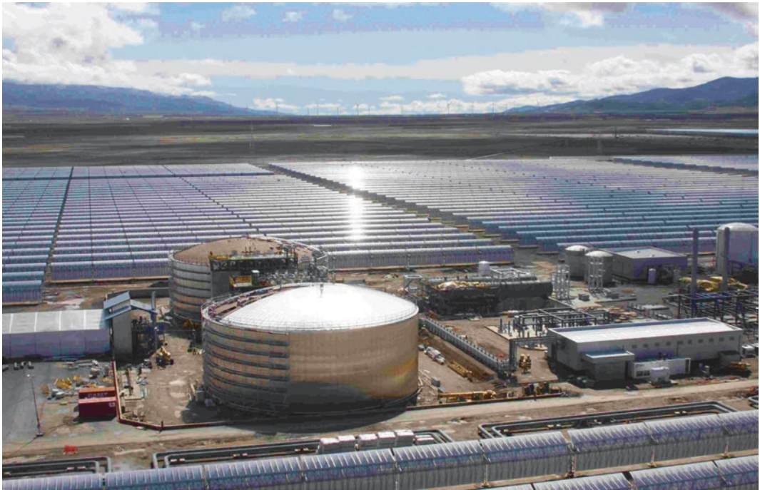
■ Abb. 13.35 Salztanks als Wärmespeicher im solarthermischen Kraftwerk Andasol I bei Guadix, Spanien (Quelle: DLR)
