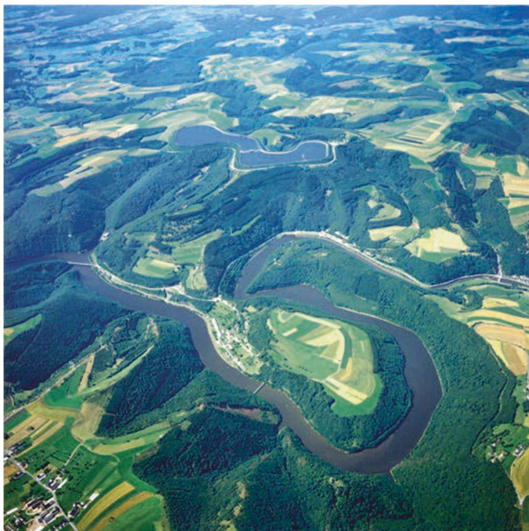
■ Abb. 13.13 Das Pumpspeicherwerk nahe Vianden in Luxemburg entlang des Grenzflusses Our zwischen Deutschland und Luxemburg. Der Fluss wird als Unterbecken genutzt (Quelle: Société Électrique de l'Our)
